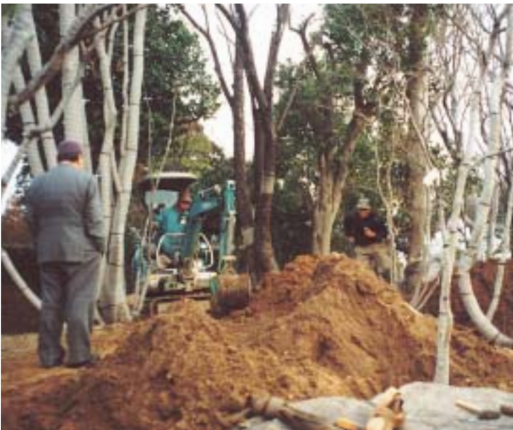
大型重機で植栽地を締め固めると、移植後に樹木の生長が著しく阻害されるこれを回避するため、樹木植栽を工事初期に行うなど植栽地の踏圧防止を行った
